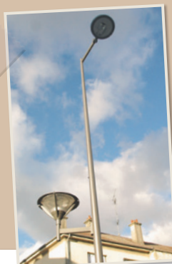
De nouveaux candélabres ont été mis en place.
